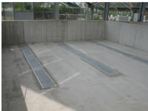
Obr.32 Sklad drevnej štiepky s podzemným potrubím k sušeniu horúcim vzduchom.
