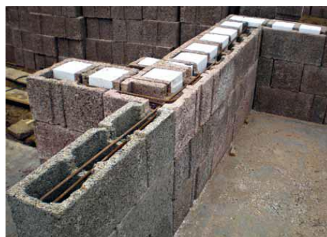
Obr.5 Stavba múru z tvaroviek Durisol
